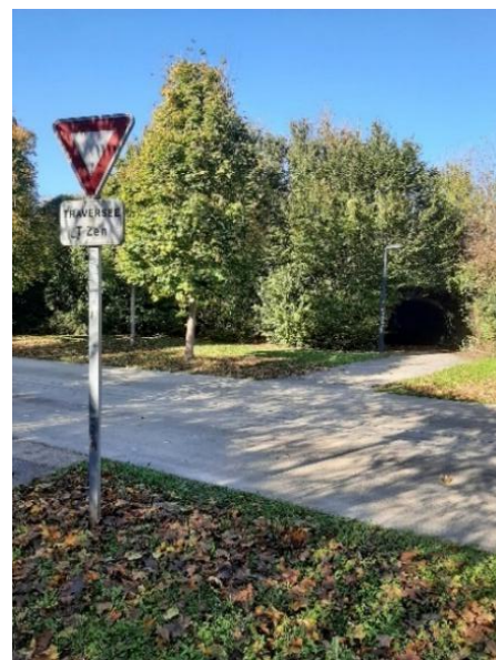
Tunnel de franchissement de la RN104 – Source : CODRA, 2024
