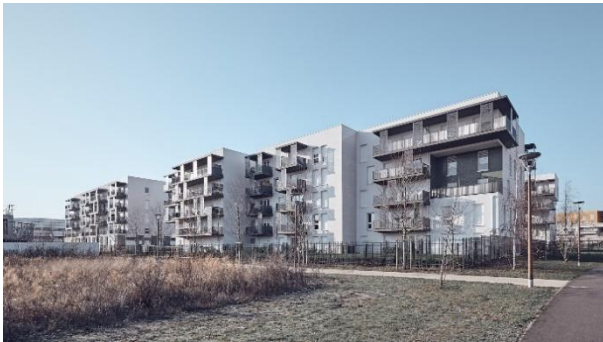
Eco-quartier de l'Eau Vive – Source : Atelier Cap Architecture
