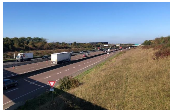
Axe autoroutier de l'A5 – Source : Codra
