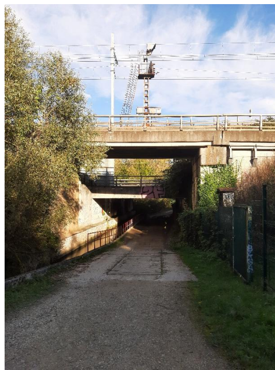
Tunnel de franchissement de la voie ferrée Source : CODRA, 2024
