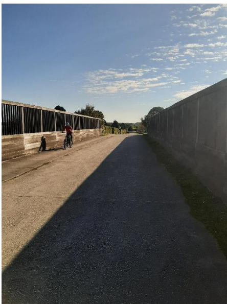
Passerelle au-dessus de la RN104/ Allée Royale – Source : CODRA, 2024
