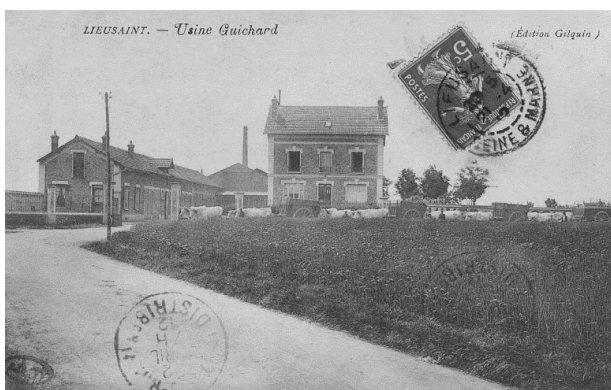
Usine Guichard – Source : Archive Départementale de Seine-et-Marne
