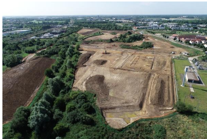
Ecoquartier de l'Eau Vive – Source : Vinci construction
