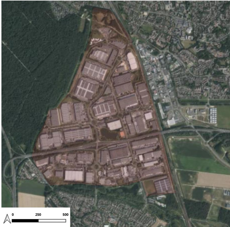
Vue aérienne de la ZAC Parisud – Source : Géoportail – Traitement : CODRA
