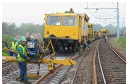
Figure 37: Longs rails soudés sur traverses béton
